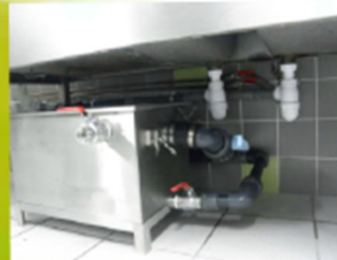
7 : remettre les vannes dans leur position normale, seule la vanne bleue est ouverte
