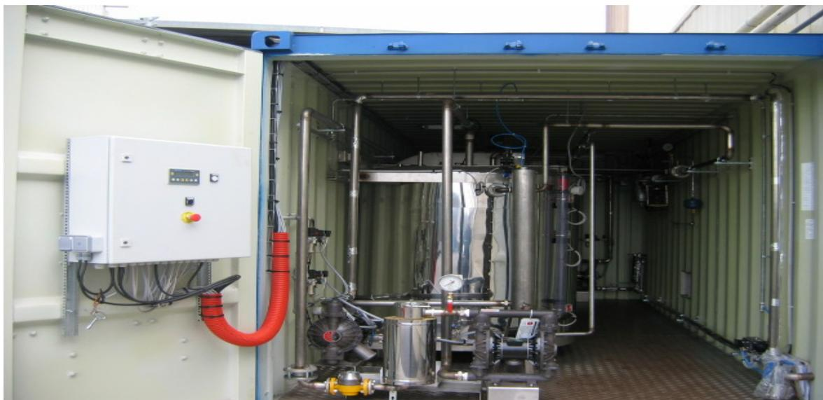
Nos installations peuvent être implantées dans des conteneurs autonomes ce qui permet de proposer un financement de l'installation. Les énergies, 5% du combustible produit, sont fournies par le client.
